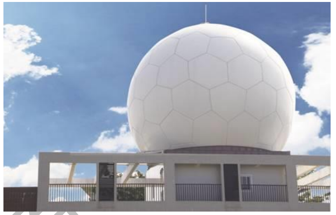
图表25: 卫星数据地面处理与存储中心
