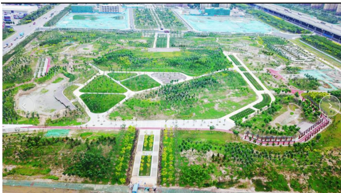
图3 天津市 8.12 危化品爆炸原址公园-海港公园 (建设中)
