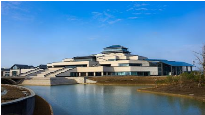
图 6：太湖国际会议中心幕墙工程
