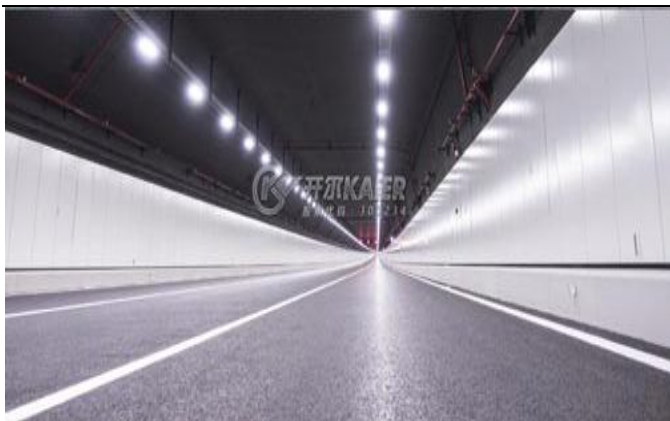
图 5：港珠澳隧桥工程
