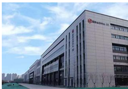
图 10：国际合作中心项目 1 期项目大楼
