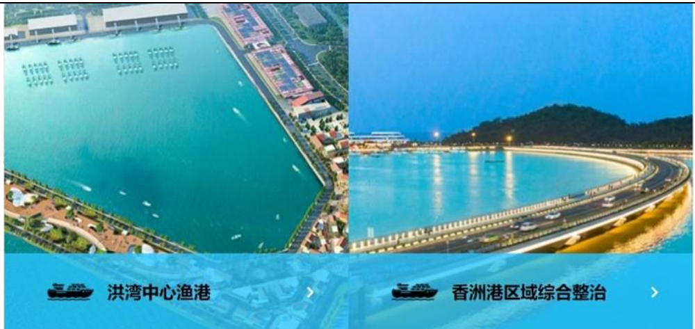
图 49: 洪湾渔港和香洲港治理实景
