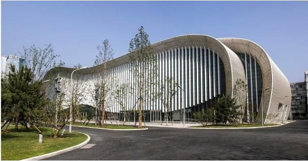
图 7：人民日报社报刊综合业务楼幕墙工程
