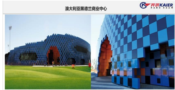
图 8：澳大利亚黑德兰商业中心外幕墙
